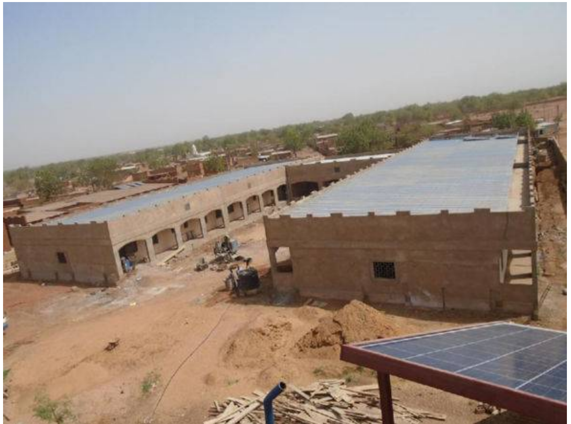
Vu du sommet du château d'eau, la maternité en fin de construction, avec au fond à droite, les panneaux photovoltaïques de la centrale.
