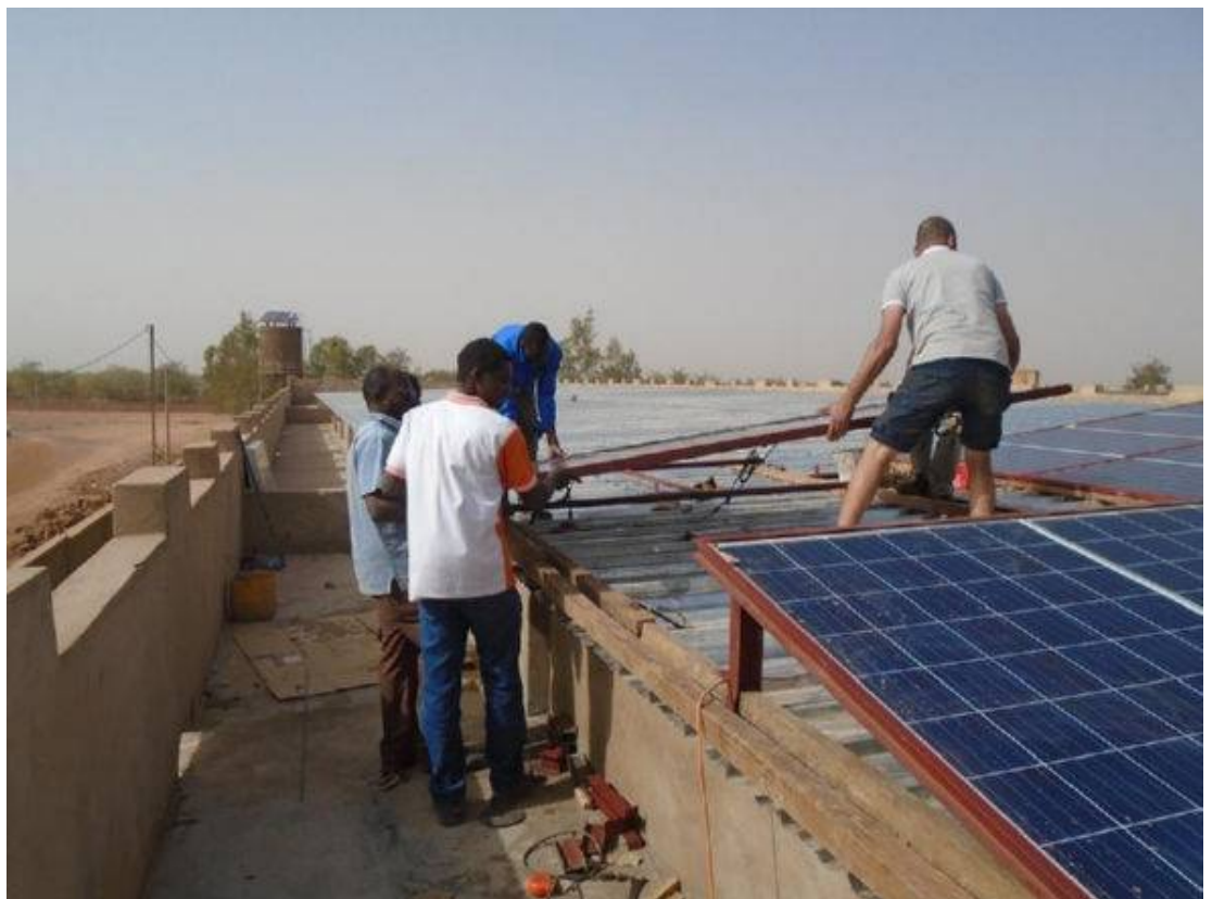
Opération délicate pour ne pas endommager les panneaux : à la manœuvre, Hippolyte Tassebedo, Lévi Kabré, Ben Ouedraogo et Philippe Etienne (de g à d).
